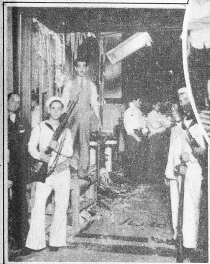
La entrada de la Pe- luquería Sixto, en la calle de Galiano, destrozada por una bomba.
