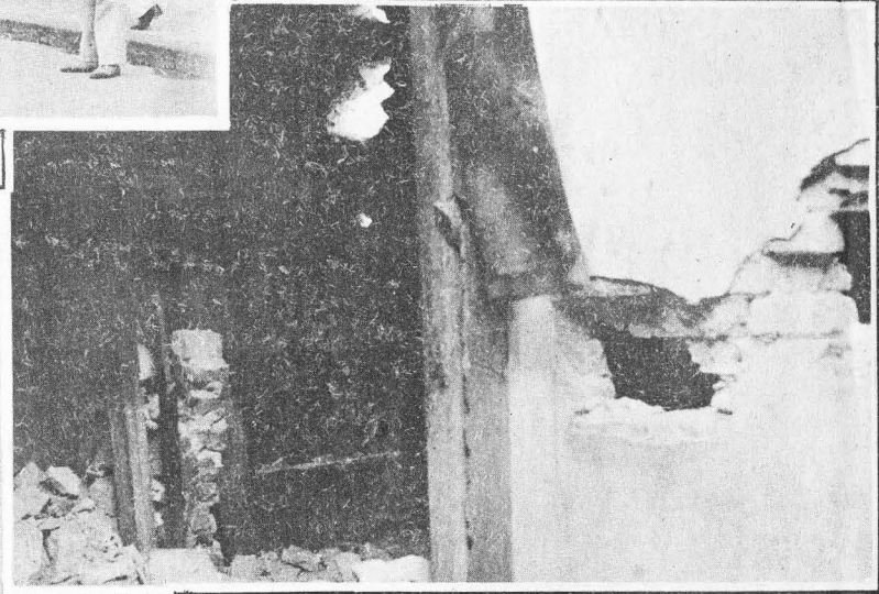
Efectos del bombardeo en el interior del cuartel de San Ambrosio.
